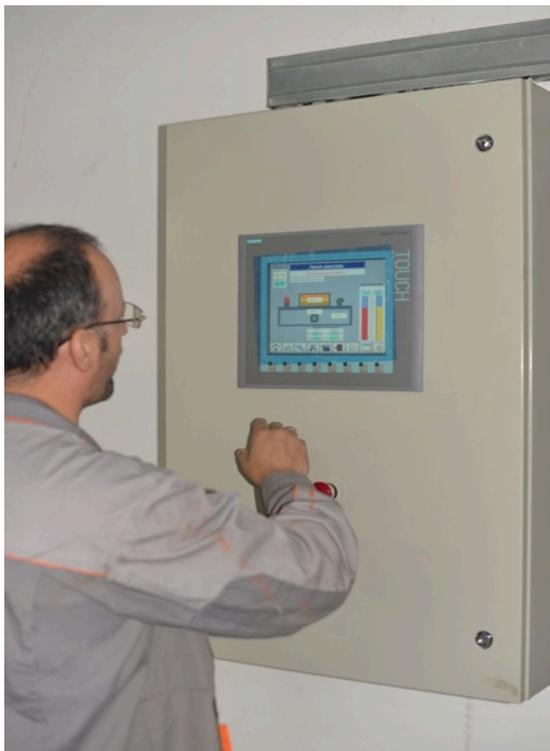
Система управления на базе промышленного контроллера с цветной сенсорной панелью оператора, размером 12 дюймов, на базе процессора SIEMENS S7-1200 и предназначена для управления печами полимеризации в тактовом режиме работы.
